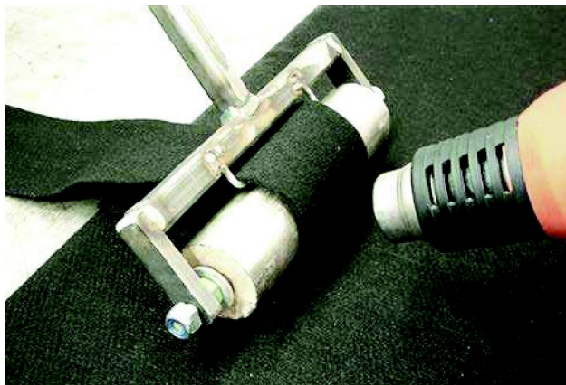
Rys. 4.2.1.2. Montaż maty wibroizolacyjnej
