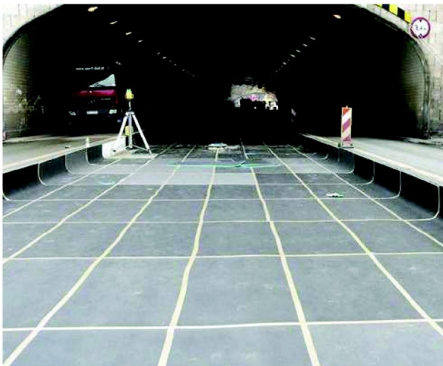
Rys. 4.1.1.2. Montaż mat wibroizolacyjnych
