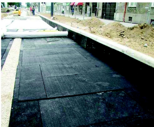
Rys. 4.1.2.2. Montaż maty wibroizolacyjnej
